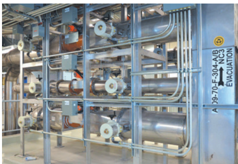
NC3 - Valves venturi isolées par des volets d'isolement (bubble tigh dampers).
