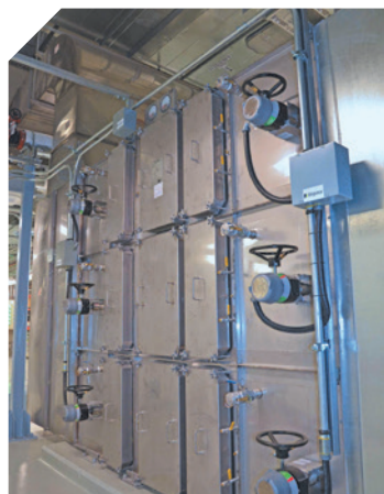
NC3 - Système de filtration type Bag-in/ Bag-out.
