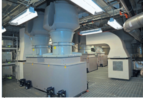
Évacuateur de dilution installé à l'intérieur (angle A).
