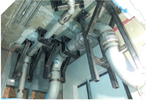
Installation de 2 conduits soudés avec structure pour le quench niveau 3, bloc D.
