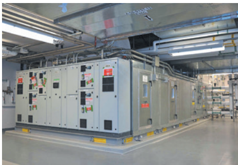
Bloc A - Salle mécanique niveau S0: unité modulaire.
