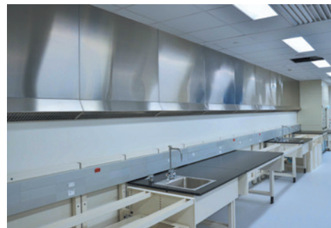
Bloc A, niveau 7 - Hotte de captation à la source (back sweep).
