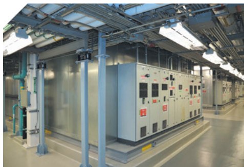
Bloc A - Salle mécanique niveau 9 finalisée.
