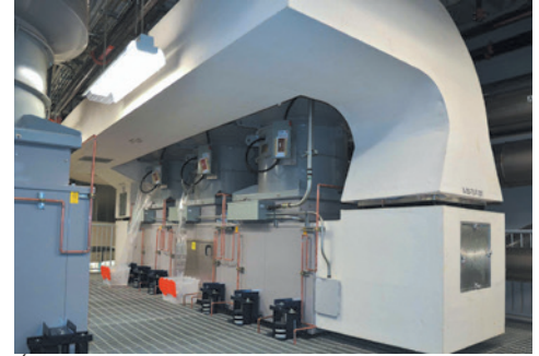
Évacuateur de dilution installé à l'intérieur (angle B).
