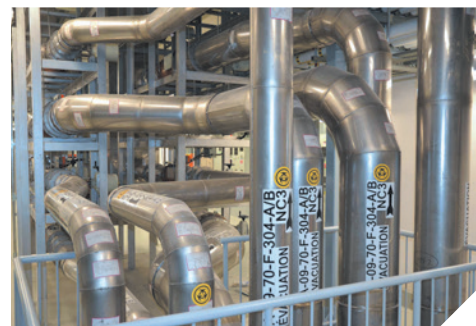
NC3 - Conduit d'évacuation 100% étanche.
