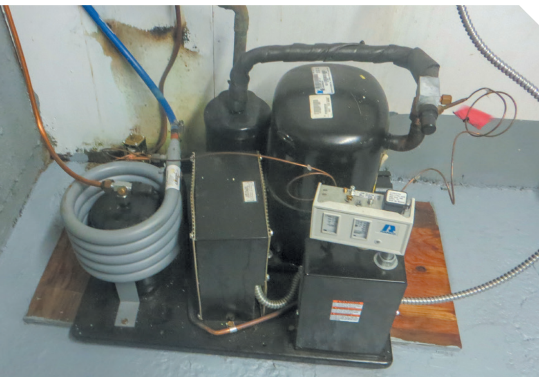
Appareils de refroidissement utilisant de l'eau potable sans boucle de recirculation le plus fréquemment utilisés dans le secteur commercial.
