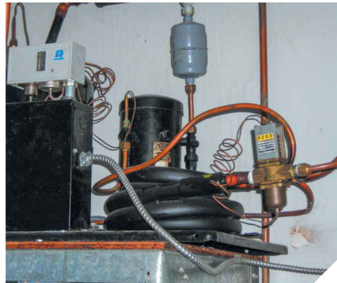
Valve de régulation du débit d'eau et l'échangeur coaxial (serpentin noir) qui caractérisent généralement ce type d'appareil.
